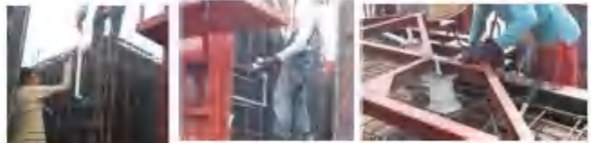
Cast-in conduit, FT & FW Pipes
